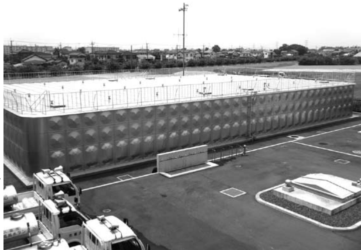
ステンレス鋼板製配水池（鷺宮浄水場）
