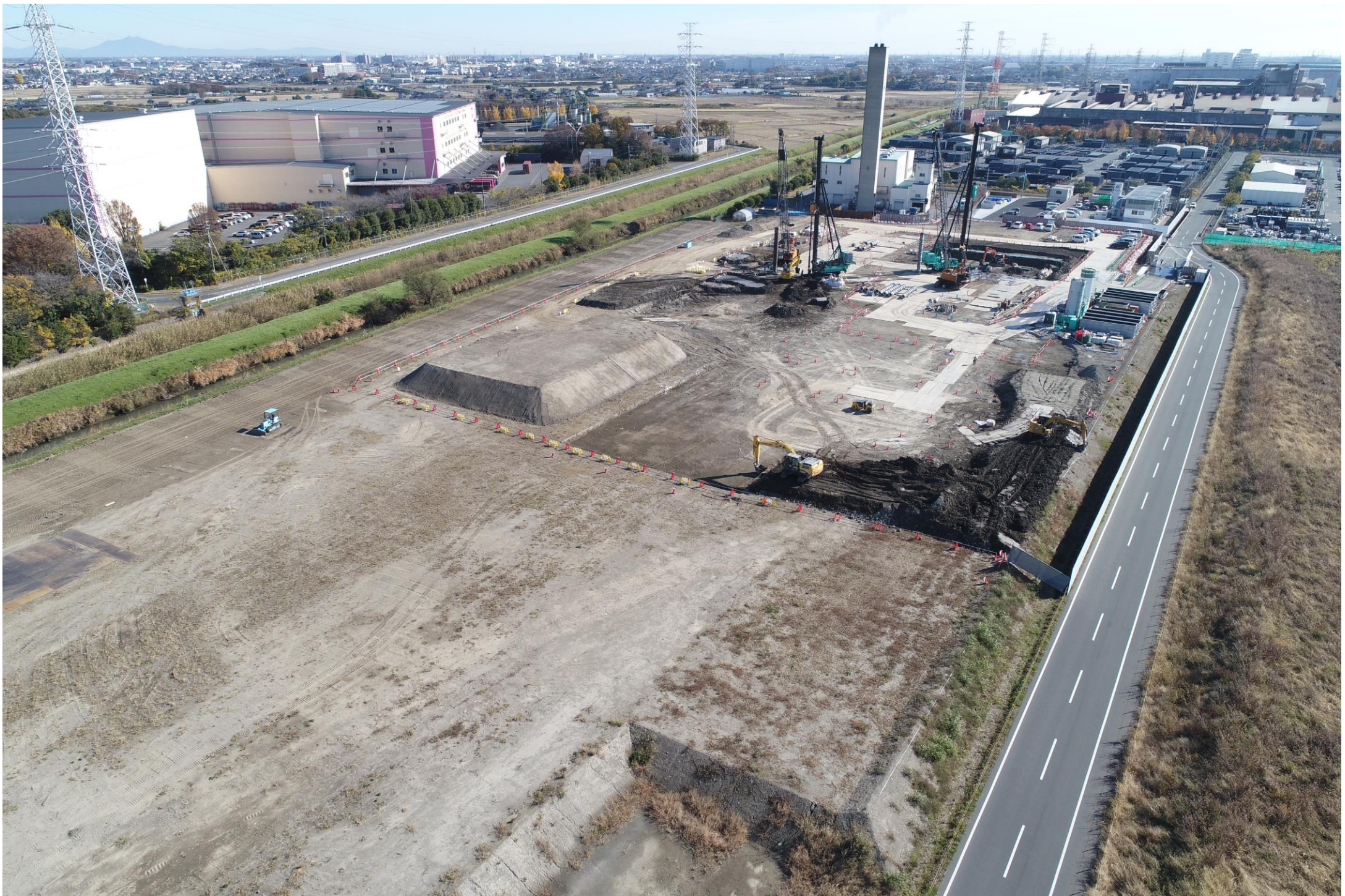
(仮称)久喜市新ごみ処理施設整備工事
