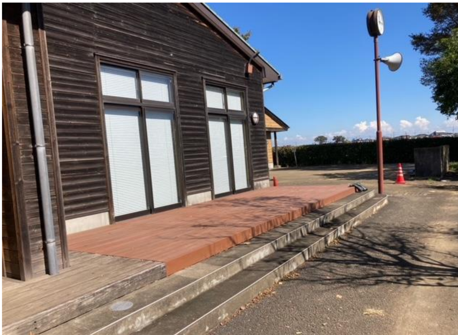
しみん農園久喜緑風館ウッドデッキ修繕
