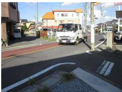
電柱を避けて通行する車両
