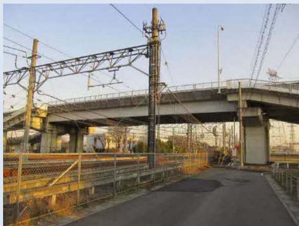
中里跨線橋(栗橋地区)
