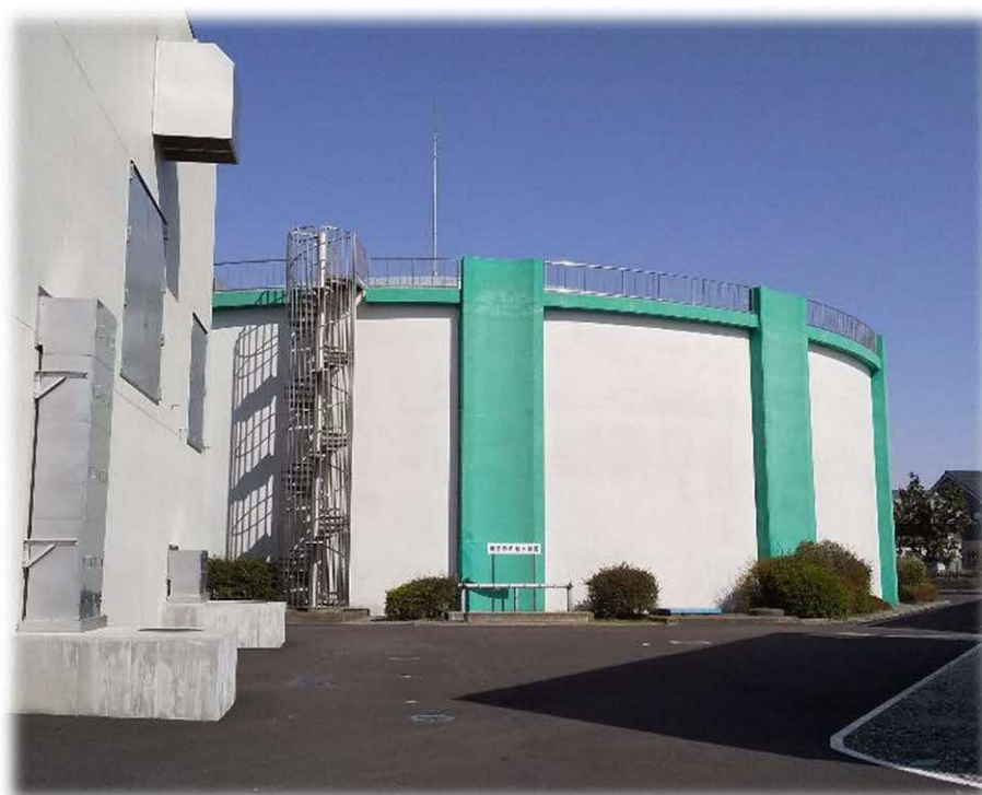
PC 配水池（吉羽浄水場）
