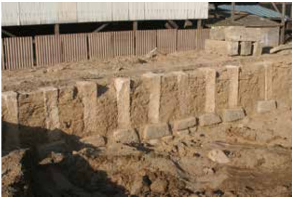
■ 移築前の蔵の基礎 盛土上の蔵を支えるため、蝸燭状に石を立てる蝸燭地業で基礎が造られていた。
