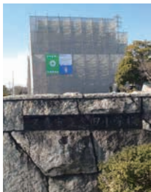
外壁改修工事中の太田小学校
