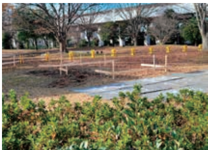
工事中の南栗橋近隣公園
