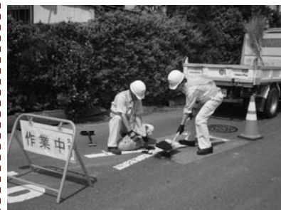
▲道路の穴埋め作業
