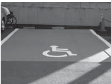
完成した障がい者用駐車場
