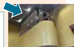
防火シャッターが設置されている吹き抜け部分
