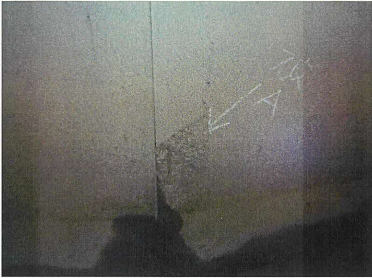
北部第4 1 雨水幹線 【雨水管渠】⑧より参照
