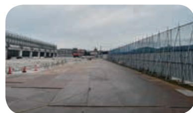
解体中のしずか館
