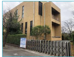
北中継ポンプ場
