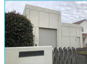
下新井中継ポンプ場
