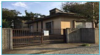
吉羽中継ポンプ場
