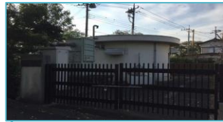
青葉中継ポンプ場
