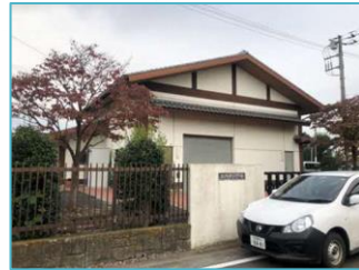
上内中継ポンプ場
