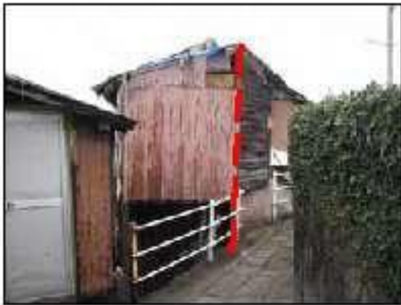
一部の柱が傾斜している例（25点）
