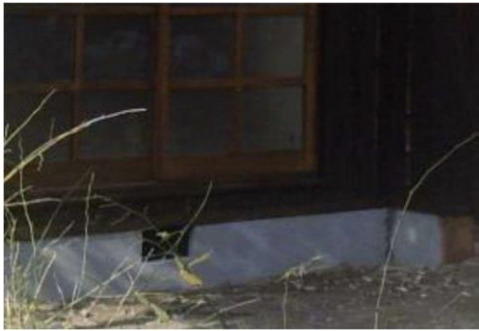
コンクリート基礎等（評点0）
