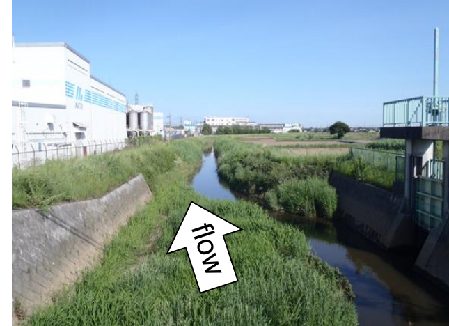
一級河川庄兵衛堀川上流端 (唐杉橋下流より)
