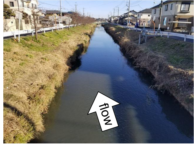
一級河川 青毛堀川 （新道橋下流より）
