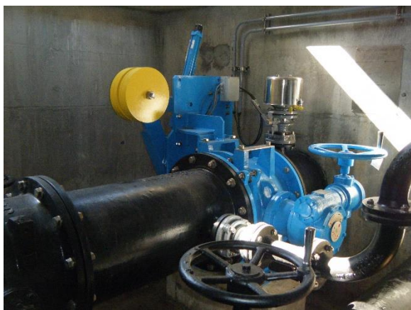
大規模地震時に配水池からの水の流出を抑える弁です。
