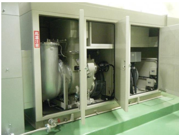
佐間浄水場の自家発電機設備更新工事
