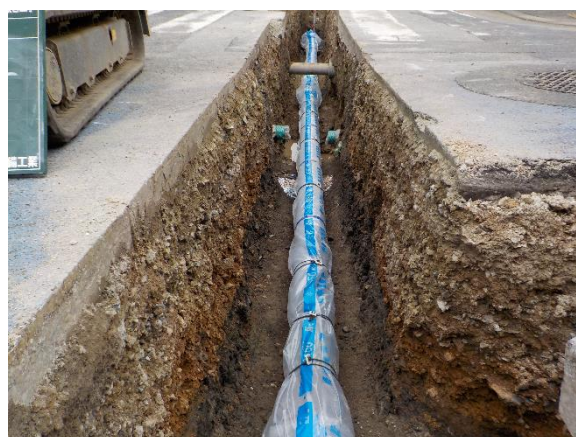
配水管の布設工事の様子です。
