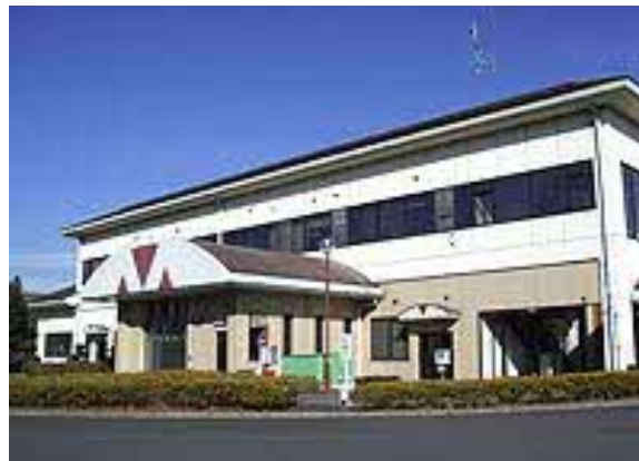
八甫清掃センターし尿処理施設
