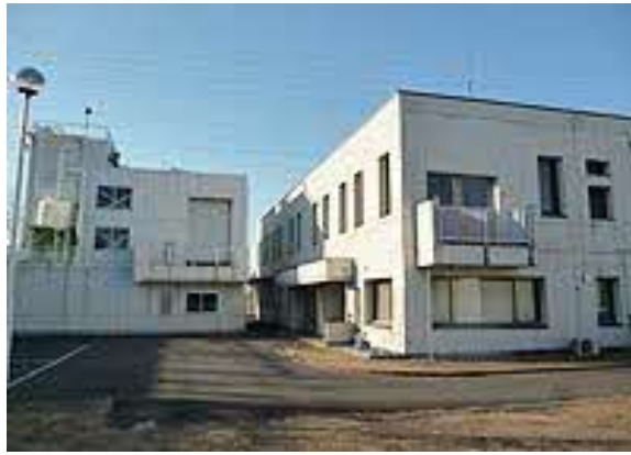
久喜宮代清掃センターし尿処理施設
