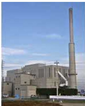
くみやしろ 久喜宮代清掃センター
