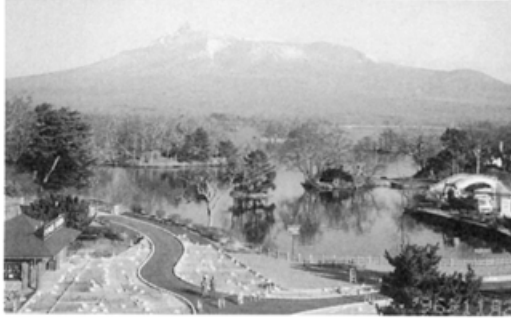
▲大沼国定公園（北海道七飯町） 北海道函館支庁より公園設計を委嘱された博士は、大正3年(1913)に改良計画を作成。翌年からこの計画を基に改良工事が進んだ。
