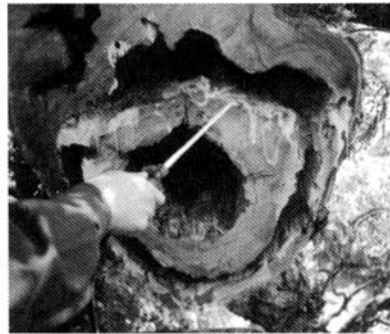
開孔腐朽部への薬剤塗布
