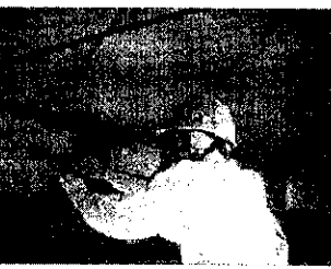
石綿の除去作業と防護服
