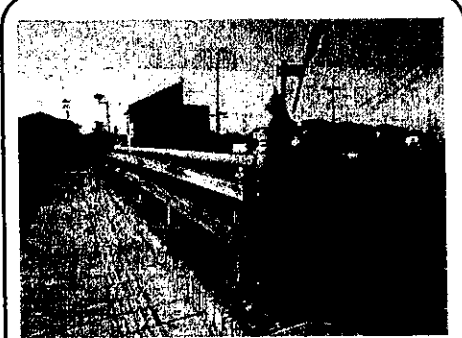
鷺宮神社近くの宮前橋。劣化が進む。
