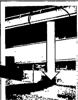
久喜東小学校の外壁落下現場
