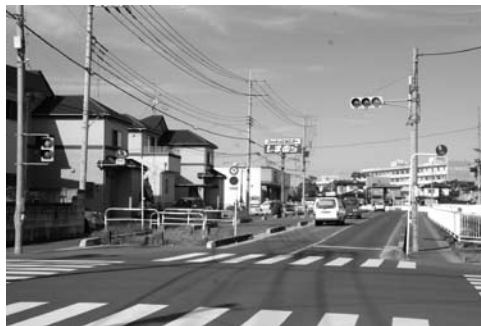
計画道路と既存道路の中間的な段階のため、歩道が変則になっている場所（栗橋地区）
