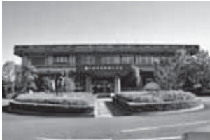
▲栗橋総合支所
