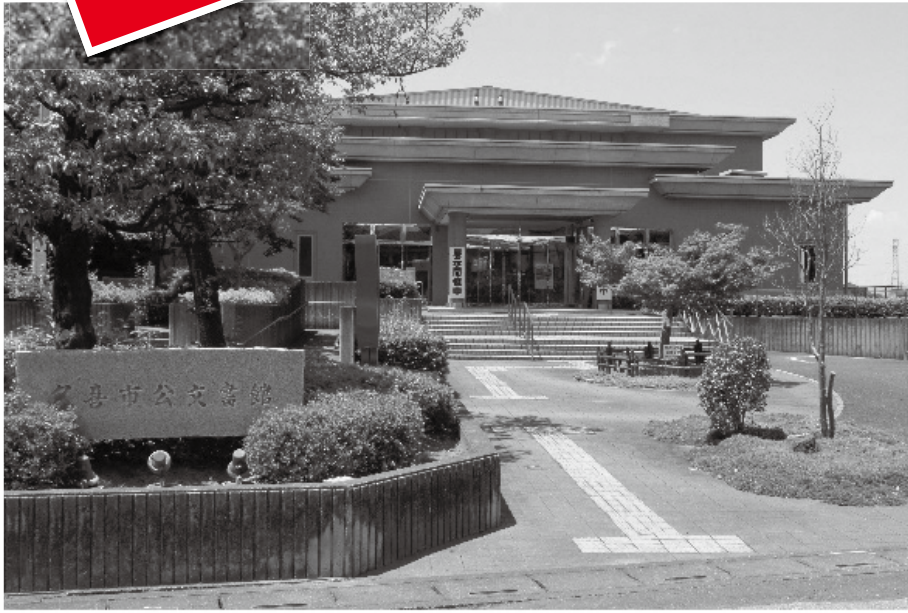
公文書館は、12月（予定）まで改修工事を行っています。
