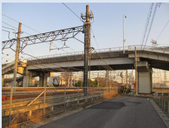
中里跨線橋(栗橋地区)
