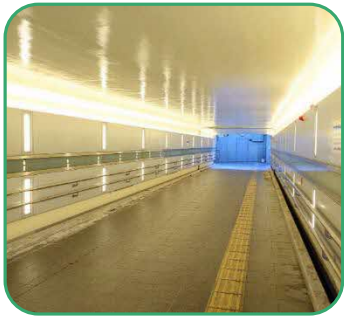
東鷲宮駅東西連絡地下道
