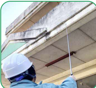
外壁全面打診調査の様子
